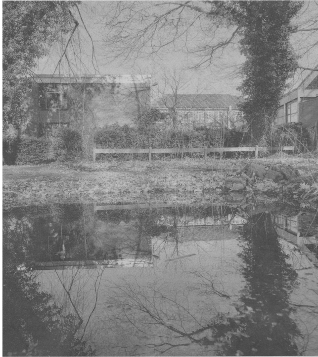
bereits angeschaut und ist zu dem Schluss gekommen: Ein Anbau ist möglich.
